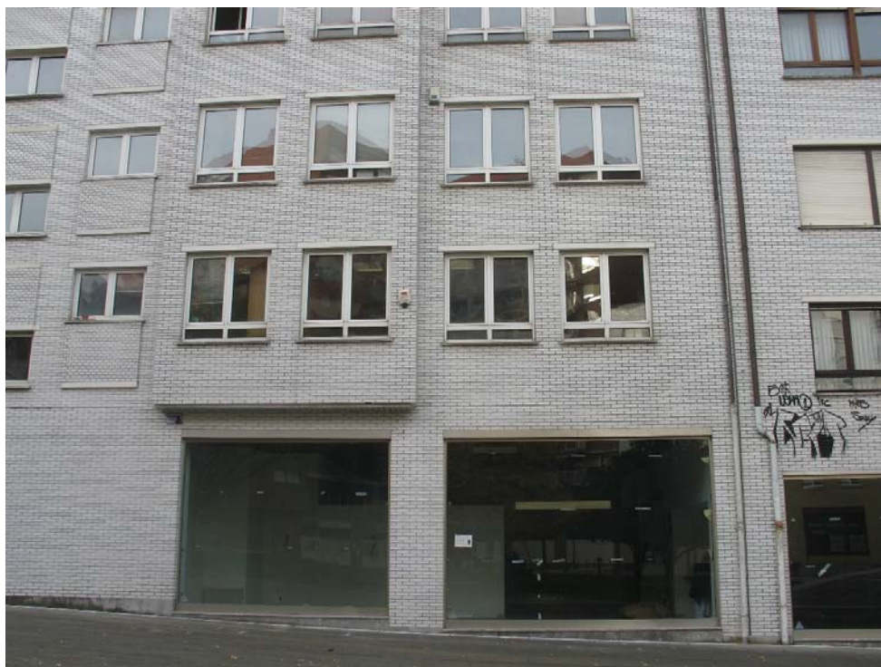
FACHADA POSTERIOR A PLAZA MARCELINO SOROA (PEATONAL)
